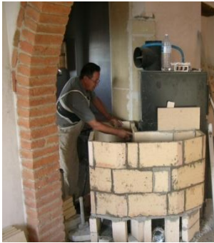
Fasi di lavorazione.
